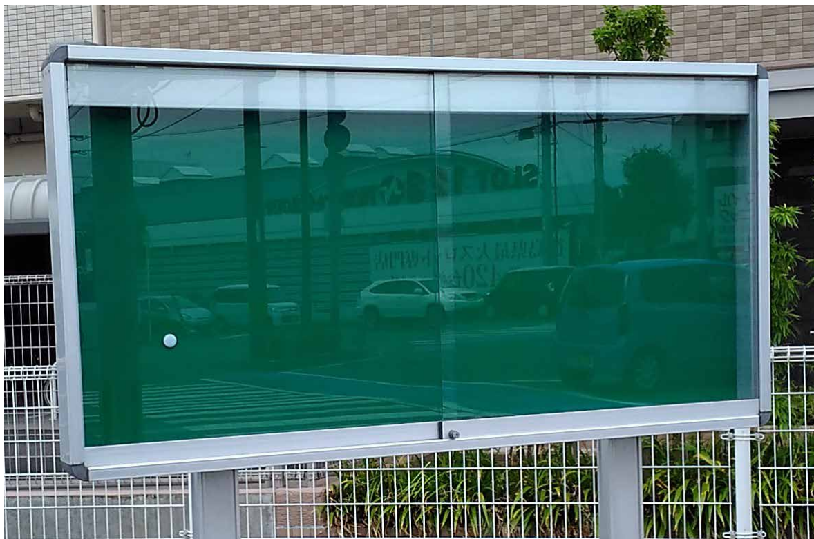
貼り替え作業後の新しくなった掲示板
