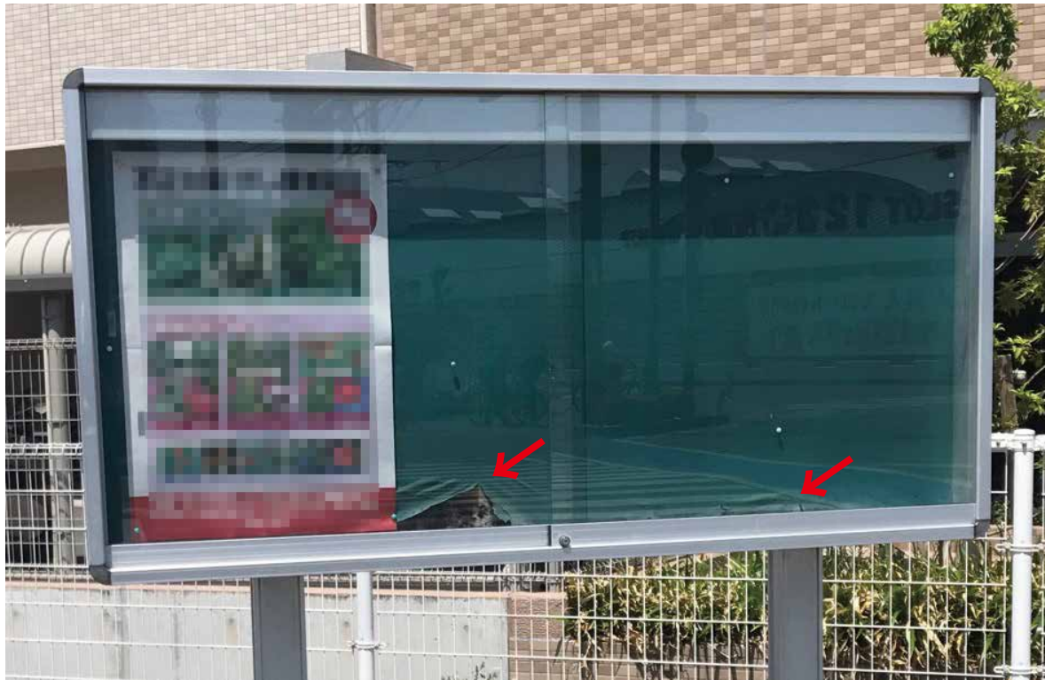
内部の板が腐食して生地がめくれあがった掲示板
